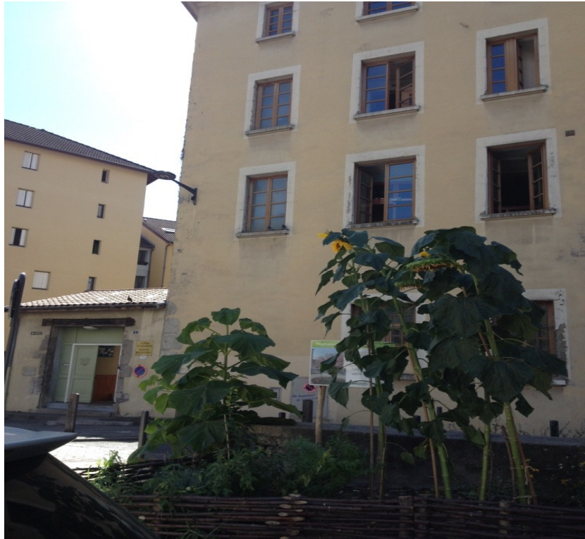
Das Studentenwohnheim von außen
